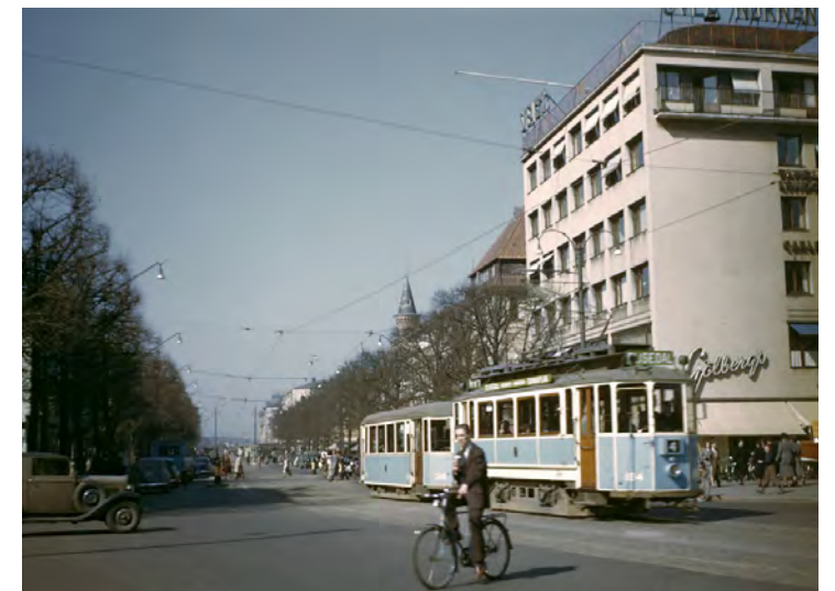
Östra Hamngatan 1948 efter att "Kopparmärta" fått lämna plats åt trafiken. Notera Arkadenhusets torn i fonden
