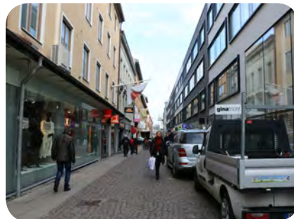
5a. P-huset har fått en ny fasad i vilken ett försök gjorts att bryta upp den stora volymen genom en färgsättning i två olika grå nyanser som växlar i takt med en småskalig husbredd.
