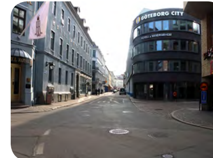
3. Här ger arkitektur från olika epoker ett variationsrikt uttryck. Alla hörn mot korsningen är mer eller mindre fasade som skapar yta till platsbildningen. Även arkaderna bidrar till platsbildningen.
